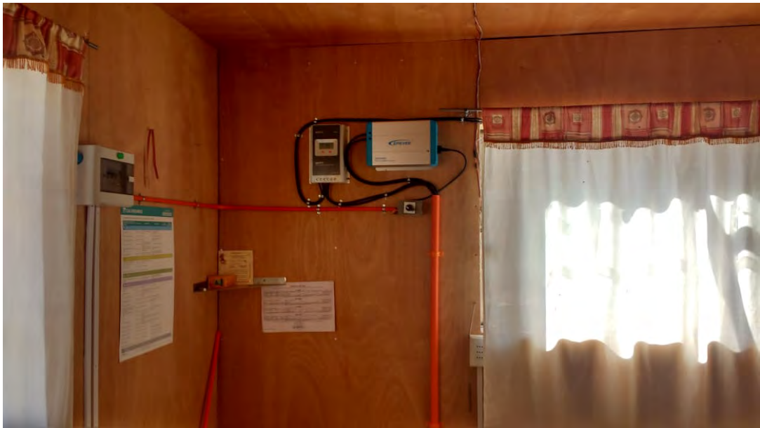
(instalación de sistema fotovoltaico en sector de Pachica, Illapata y Codpa )
