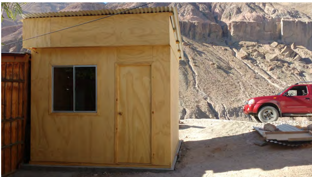
(instalación de recinto 3x3 en sectores de Codpa, Esquiña, Cerro Blanco (Illapata)
