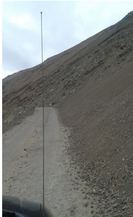
Imagen 6: Material meteorizado, con alta pendiente y nivel geodinámico característico de zonas de Riesgo Alto de Remoción en Masa.
