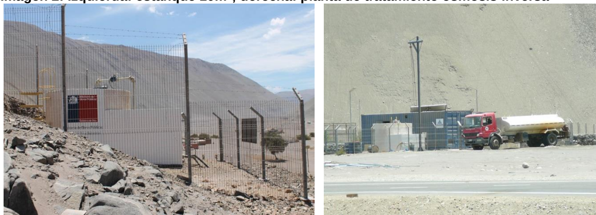
Imagen 2: Izquierda: estanque 10m 3 ; derecha: planta de tratamiento osmosis inversa
