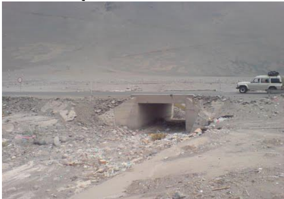
Cruce Ruta 5 Quebrada de Chiza
