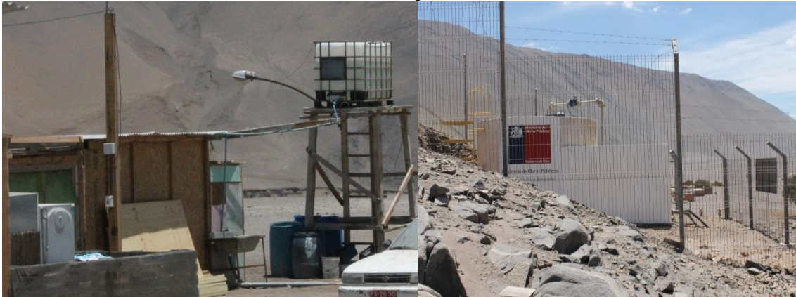
Fotografía 9: Estanques de almacenamiento de agua potable en Caleta Camarones – APR Cuya.
