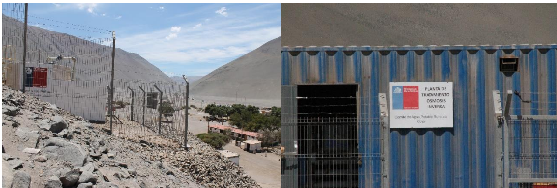
Fotografía 2: APR y Planta de Osmosis Inversas - Cuya
